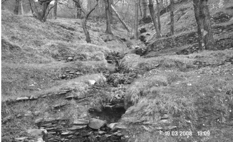
*Figura 7: Perlezzì Cascinelle. Canale dell'acquedotto lungo i terrazzamenti relativi alla fase della prima metà del XVIII secolo. A sinistra dettaglio del modo in cui lungo le terrazze la corsa dell'acqua viene rallentata per consentire la derivazione delle diramazioni per l'irrigazione delle terrazze stesse. Al centro e a destra particolari del rivestimento in lastre di scisto del canale dell'acquedotto lungo le terrazze.*
