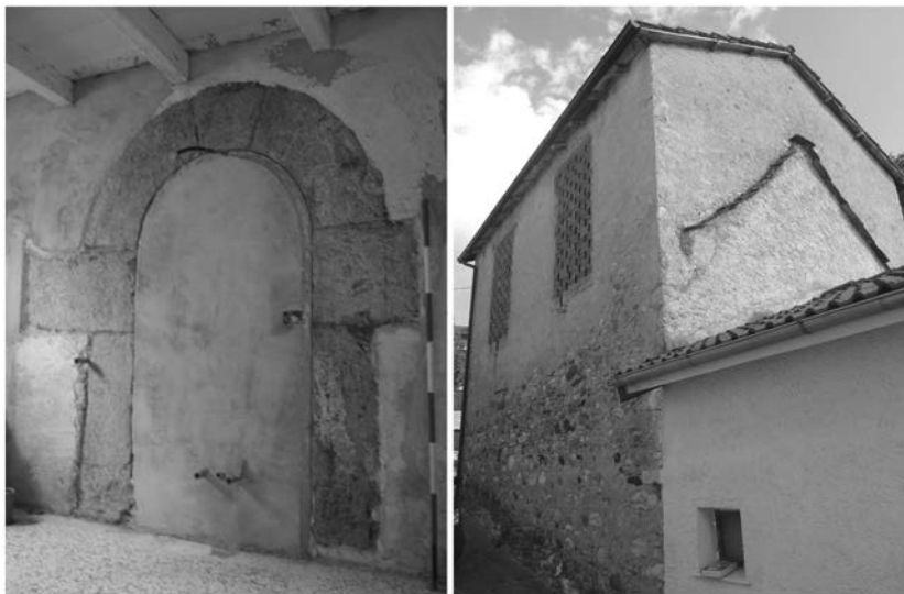
Figura 6: Casanova. A sinistra. Ventarola, portale ad arco riferibile alla fine del XVI secolo relativo al primo piano di una struttura di accoglienza per muli e mulattieri. A destra. Racosta, stalla con soprastante fienile costruita nel 1914 (informazione del proprietario sig. Rapuzzi), addossata a precedente fienile con tetto a spiovente piuttosto inclinato non conservato.
